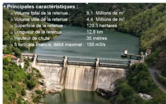
Barrage et retenue de Pinet
